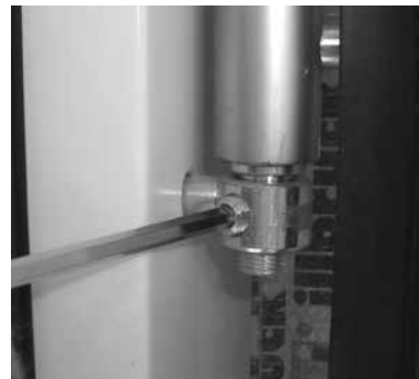
Fixierschraube lösen.
