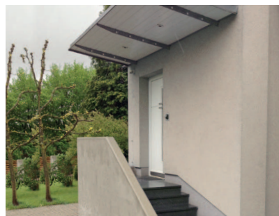
Bild 3: TEILGESCHÜTZTE LAGE laut ÖNORM B 5339:2009 Einbausituation mit baulicher Maßnahme, welche die Bewitterung der Außentüre durch Wind zulässt und teilweise vor Schlagregen schützt.
