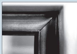
Dichtungsmontage Rahmenstock: richtig ✓
