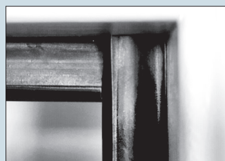
Dichtungsmontage Rahmenstock: falsch ✗
